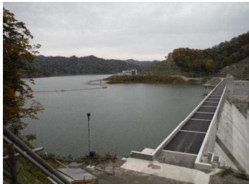
2014/10/6 試験湛水 貯水位 297.0m
