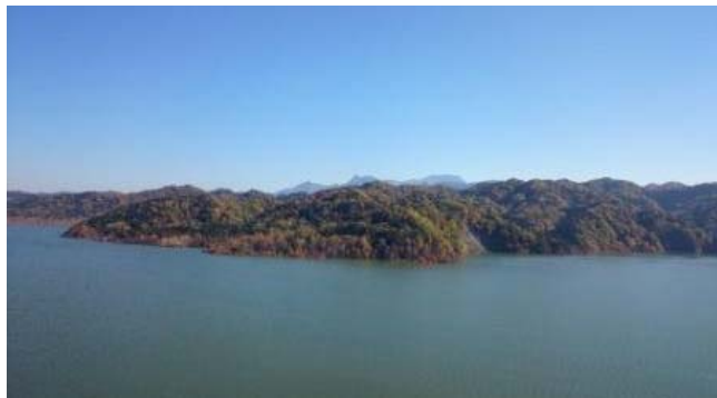
2014/10/7 試験湛水 貯水位 297.1m
