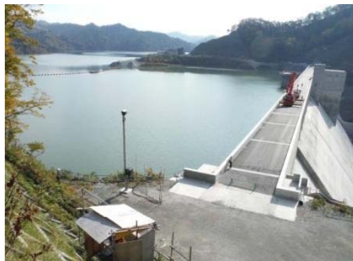
2014/10/8 試験湛水 貯水位 297.1m
