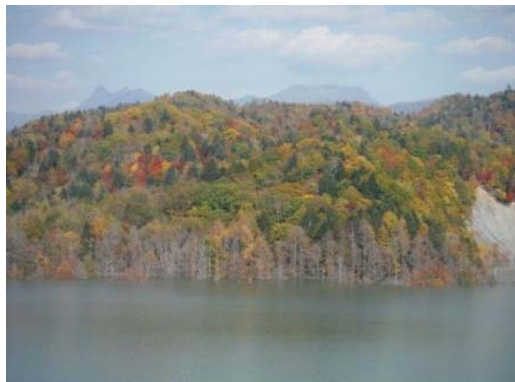
2014/10/9 試験湛水 貯水位 297.2m
