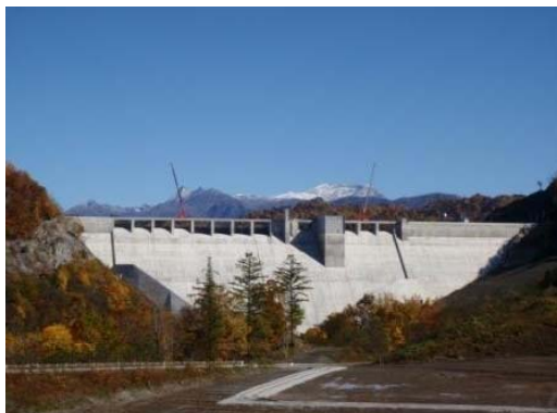
2014/10/15 試験湛水 貯水位 297.6m
