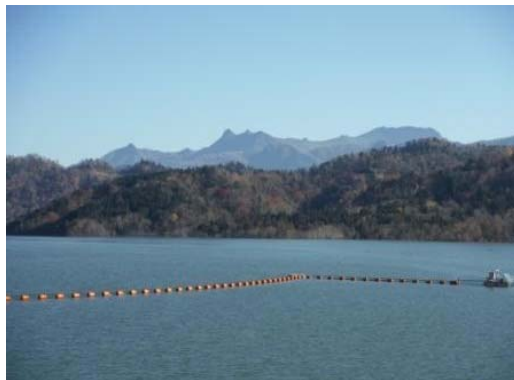
2014/10/23 試験湛水 貯水位 298.7m
