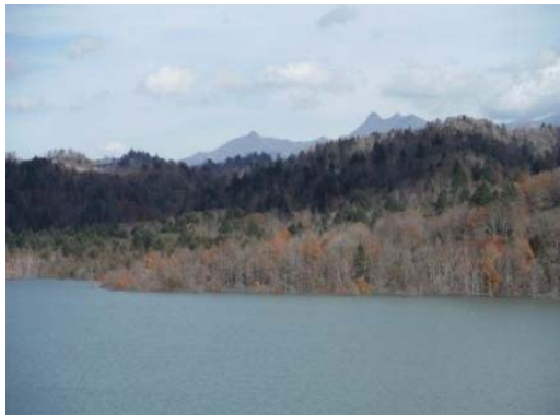
2014/10/24 試験湛水 貯水位 298.8m
