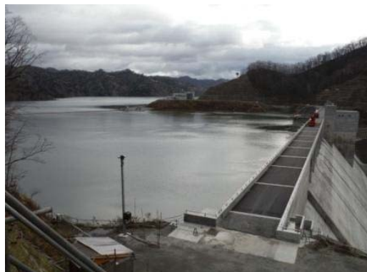
2014/10/28 試験湛水 貯水位 299.1m
