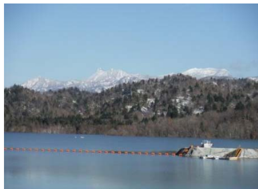
2014/10/30 試験湛水 貯水位 299.3m
