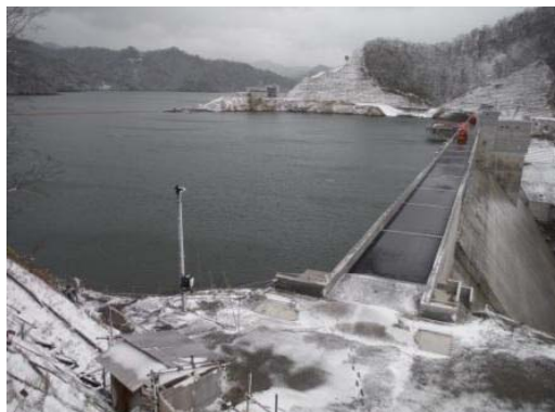
2014/11/4 試験湛水 貯水位 300.4m
