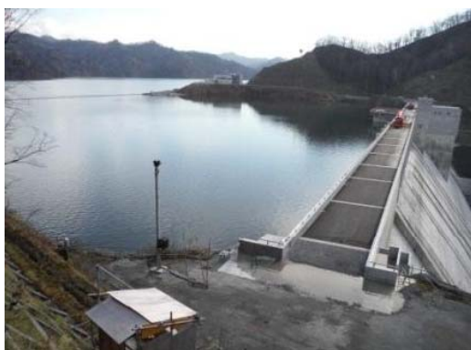
2014/11/6 試験湛水 貯水位 300.81m (9:00現在)
