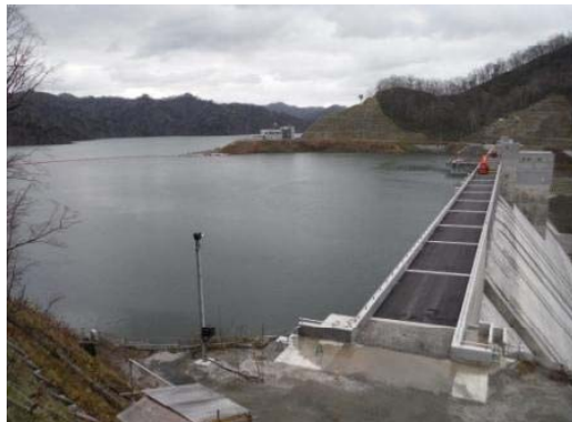
2014/11/9 試験湛水 貯水位 301.10m (9:00現在)
