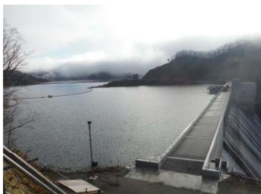
2014/11/11 試験湛水 貯水位 301.31m (9:00現在) 301.33m (15:00現在)
