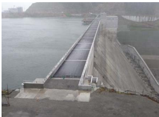
2014/11/13 試験湛水 貯水位 301.51m (9:00現在)
