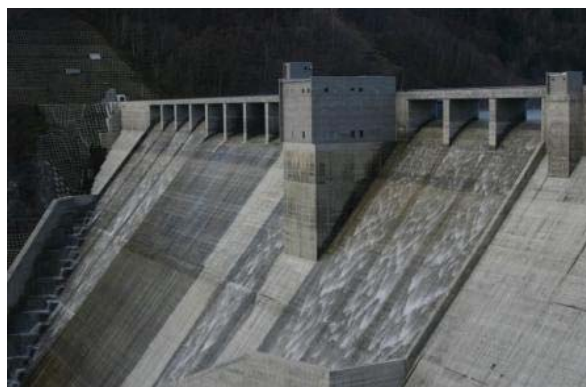
2014/11/13 試験湛水 貯水位 301.53m (15:00現在)
