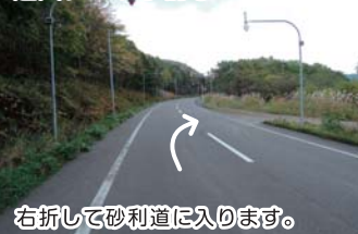
進入ゲート手前②
