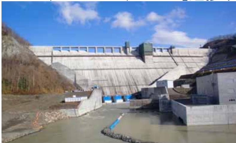
25年11月堤体下流より
