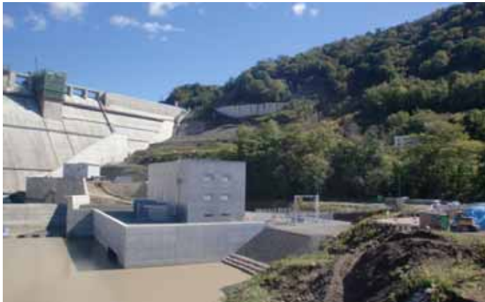
25年9月発電所建設工事
