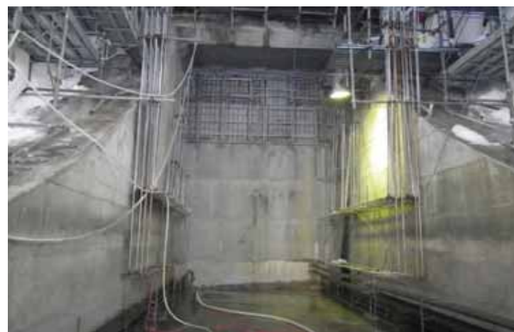
26年1月末 堤内仮排水路閉塞
