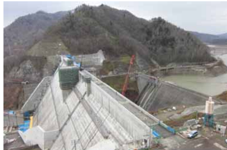
25年11月堤体左岸より
