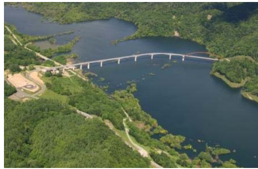
明石駅付近(新白銀橋)
