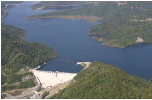
夕張スーパーダム
