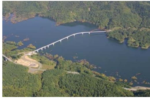
明石駅付近(新白銀橋)
