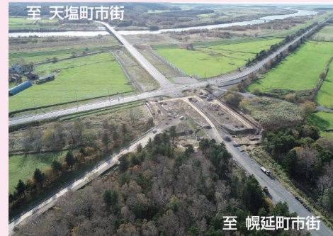
至 天塩町市街 至 幌延町市街 国道40号 天塩防災 工事状況
