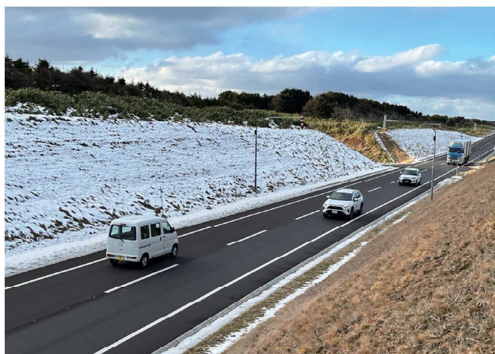
浜猿防災の部分開通（猿払村知来別工区）
