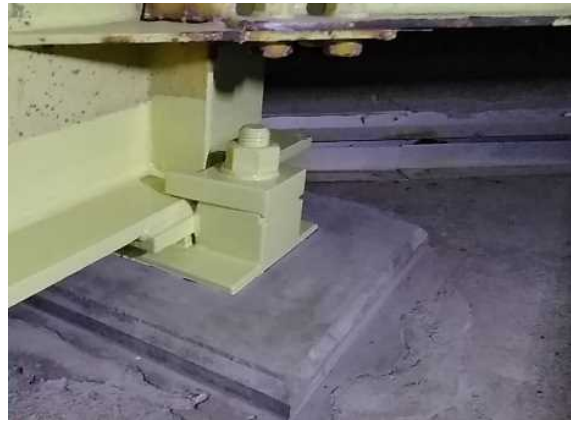
【橋梁修後(支承)】
