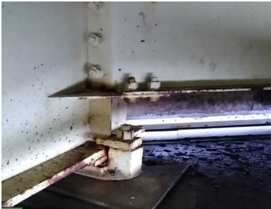
【橋梁補修前（支承）】
