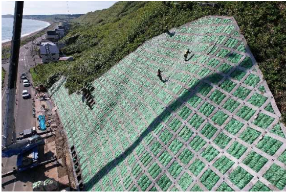
【防災対策法枠工】
