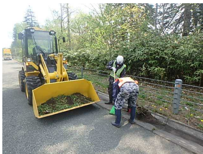
【排水構造物清掃】
