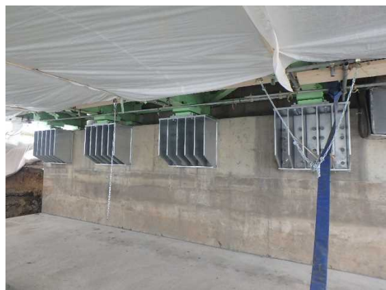
【耐震補強（水平力分担構造）】
