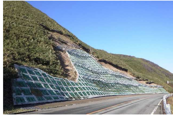
【防災対策完了】
