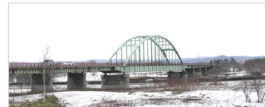
写真1：現在の天塩大橋全景
