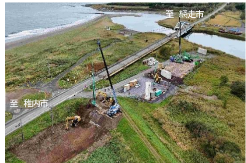
国道238号 幌別橋架替
