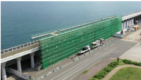
稚内港 北防波護岸改良
