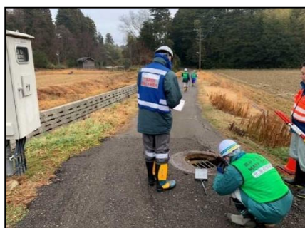
【農業集落排水施設の調査】
