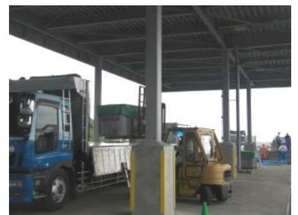
水産物の生産から陸揚げ、流通・加工までの一貫した衛生的な供給システムの構築にあたり、直射日光や鳥糞などの排除を目的とした屋根付き岸壁や清浄海水導入施設などの衛生管理型漁港づくりを行っています。
