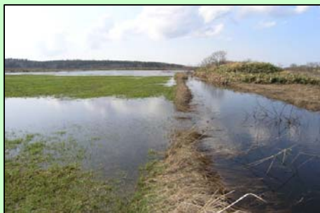
排水路から農地への溢水
